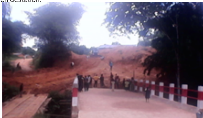
Construction d'un pont sur la route Kindu-Kasongo
